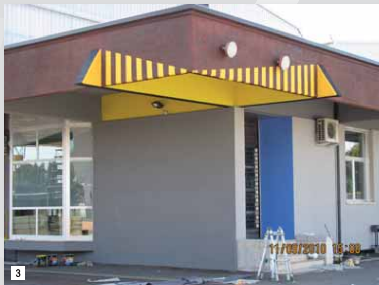
3 Steel distribution centre, firm Strada (Brescia, Italy), concrete surfaces treated with a COR-TEN® effect coating; project Jorrit Tornquist. Centro distribuzione acciai, ditta Strada, Brescia, superfici in calcestruzzo trattate effetto COR-TEN®; progetto Jorrit Tornquist.
