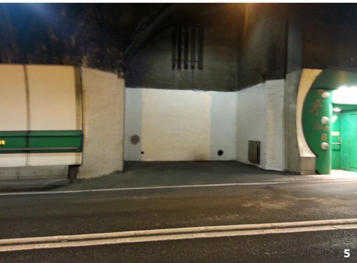
era verificato alcun viraggio del colore, l'adesione era buona e la superficie facilmente lavabile. Il test prosegue per almeno 12-18 mesi per validare l'applicazione.
